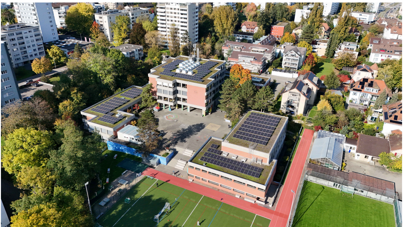
Fotovoltaikanlage Schulhaus und Turnhalle Mühlematt, Lindenstrasse 19 / Foto: Max Schwank, 2025
