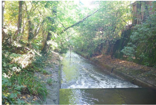
Beginn Abschnitt mit Schwelle
