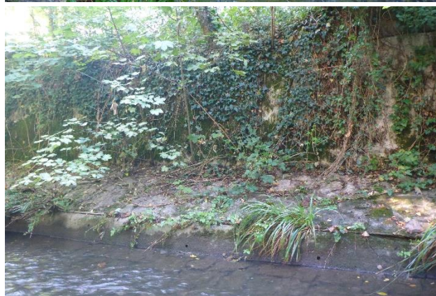
Betonmauer mit Efeu
