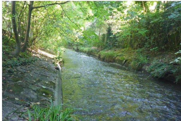
Hart verbautes Gerinne&Ufer
