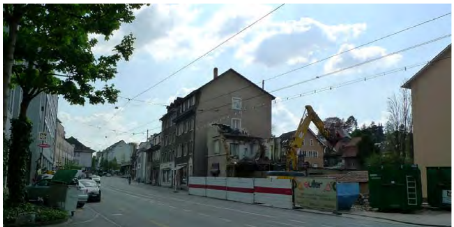
Abb. 8: Gebäude Hauptstrasse 10 (Abbruch) und Hauptstrasse 12/14
