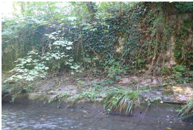
Betonmauer mit Efeu
