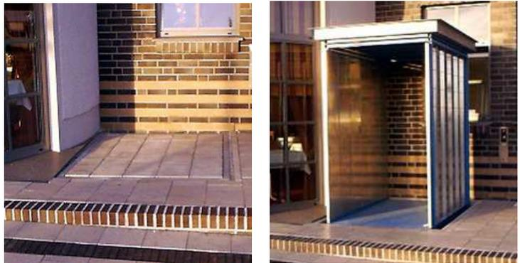
Für den neuen Aufzug konnten mit einem sogenannten „Behinderten-Baldachin-Lift“ und einem Senkrecht-aufzug zwei Lösungen gefunden werden, die beide in den bestehenden Aufzugsschacht passen und über eine nachgewiesene sichere und zuverlässige Technik verfügen, die in der Schweiz an verschiedenen Orten im Einsatz ist.
