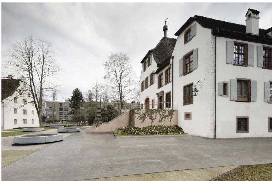
Bei dieser Variante wird ein neuer Treppenaufgang von vorne errichtet. Die bestehende seitliche Zugangstreppe wird vollständig zurückgebaut. Die Brüstungshöhe der Mauer ist reduziert. Das Podest sowie die Treppenläufe sind mit neuen Geländern versehen.<sup>3</sup>
