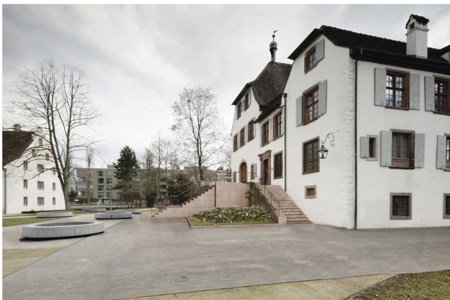
Bei dieser Variante wird ein neuer Treppenaufgang von vorne errichtet. Die bestehende seitliche Zugangstreppe wird belassen – aber verschmälert. Die Brüstungshöhe der Mauer ist reduziert. Das Podest sowie alle Treppenläufe sind mit neuen Geländern versehen.<sup>2</sup>
