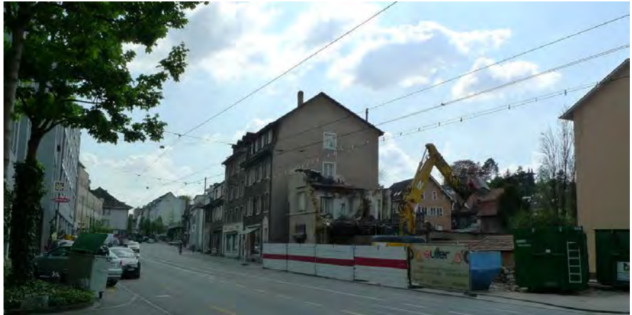
Abb. 7: Gebäude Hauptstrasse 10 (Abbruch) und Hauptstrasse 12/14
