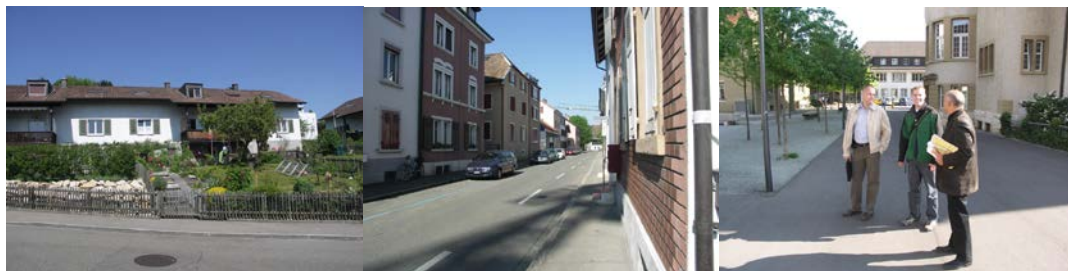
Abb. 8: (v.l.) Wohnbausiedlung Spiegelfeld, Strassenzug Kernmattquartier, Ortsbegehung mit der kantonale Denkmalpflege (Herr Billerbeck) und dem Kreisplaner (Herr Wehren) und der Gemeinde (Herr Reher). Bilder Markus Vogt Planteam S AG.
