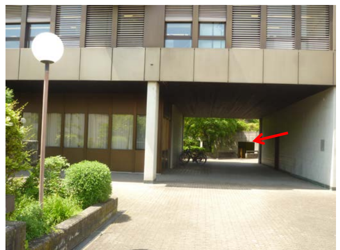
durch den Durchgang zu den Bauabteilungen
