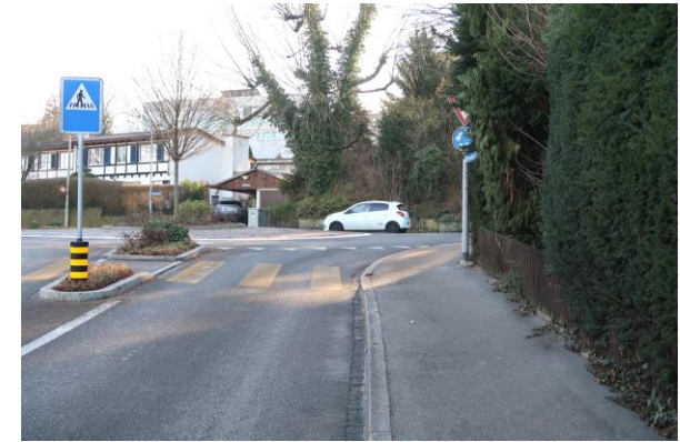
Sicht auf Kreiselparadiesstrasse; Verdeckte Signale
