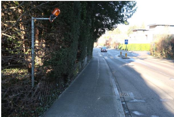
Eingeschränktes Lichtraumprofil, Blinklicht bei Ausfahrt Haus 96
