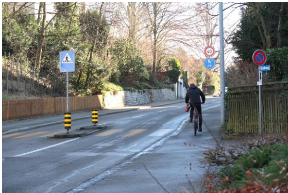
Neubadstrasse Höhe Huebweg (Gemeinsamer Fuss-/Radweg)
