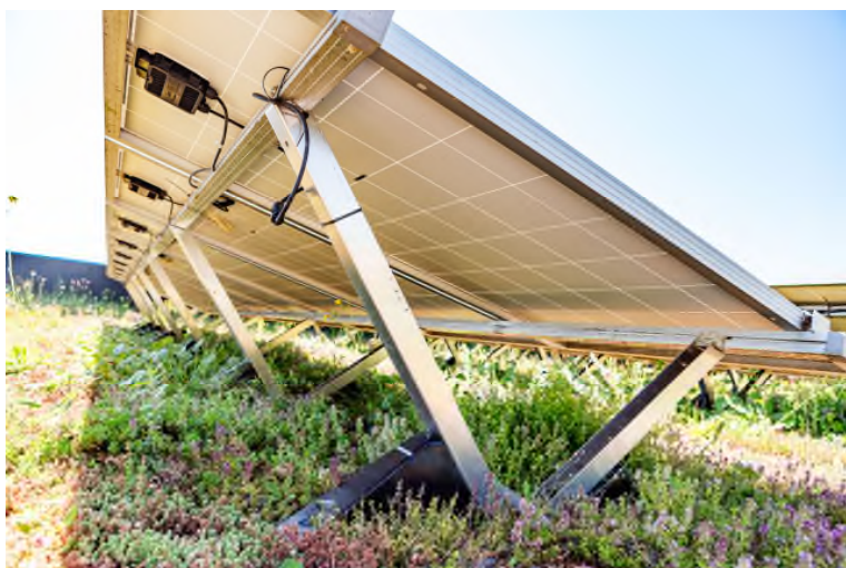
Typische Unterkonstruktion für Gründächer
